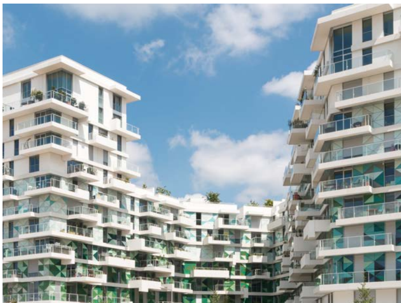
Wohnanlage Residence Unik - Zac Seguin, Paris, FR Bauherr: Nexity, Paris, FR Planung: BECKMANN N'THEPE ARCHITECTS, Paris, FR Sto-Kompetenzen: StoVentec Glass, StoVentec R, StoTherm Classic Foto: Manuel Panaget, FR
