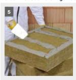
platten kann eine spezielle Klebepistole z.B. PFT oder Putzmeister eingesetzt werden. Die Dämmplatten weber.therm MW 035 Fassade express und weber.therm MW 035 Fassade standard werden rahmenförmig an den Plattenrändern mit drei senkrechten Streifen mit Klebemörtel beschichtet (Abb. 5).
