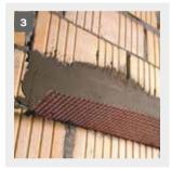
b) Sockelabschluss ohne Profile (umputzter Sockel): Hierzu wird ein Panzereckwinkel weber.therm 312 mit Klebe- und Armierungsmörtel weber.therm 302 auf der Wand befestigt, in den später die Dämmplatten geklebt werden (Abb.3).
