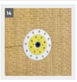
Bei der Verdübelung durch das Gewebe werden die Dübel sofort nach dem Einbetten des Armierungsgewebes gesetzt. Der Mörtel darf vorher nicht aushärten! Anschließend werden die Dübelköpfe mit Armierungsmörtel überzogen (Abb. 14).
