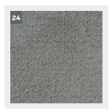
Hierbei darf weder das Gewebe freigelegt werden, noch darf eine Sinterhaut an der Oberfläche entstehen (Abb. 24). Zwischen Armierungsmörtel und Fensterbank muss eine Trennung ausgeführt werden.
