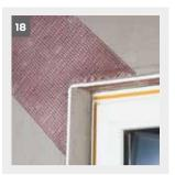
Hierbei muss zusätzlich ein Stück Panzereckwinkel innen in der Laibung angebracht werden, damit auch hier eine durchgehende Armierung vorhanden ist. Bei Verwendung von Putzprofilen werden diese mit Profilansetz- und Installationsmörtel weber.mix 125 unter Berücksichtigung der Dicke des ausgesuchten Putzsystems entweder direkt auf die Panzereckwinkel oder auf die Armie-
