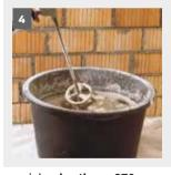
Die Platten müssen vor Feuchtigkeit geschützt gelagert werden. Durchnässte oder schadhafte Platten dürfen nicht eingebaut werden. Die Verklebung erfolgt mit dem Klebe- und Armierungsmörtel weber.therm 302. Bei nicht saugenden Untergründen z.B. dichter Beton oder Klinker sollte der Klebemörtel
