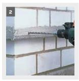
Für den Sockelabschluss stehen zwei Varianten zur Verfügung: a) Ein zur Plattenstärke passendes Sockelprofil in Trogform wird mit Profil-Dübeln weber.therm 342 (3 Stück pro laufender Meter) angebracht (Abb. 2) und mit Sockelverbindern montiert. Zusätzlich kann das Profil auf ganzer Länge in Profilan-
