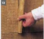
Kleinere Lücken können mit weber.therm 345 B 1-Füllschaum ausgeschäumt werden (max. Fugenbreite 1 cm).
