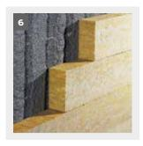
Der Mörtel ist so zu verteilen, dass nach dem Andrücken der Platte mind. 50 % der Fläche mit dem Untergrund verbunden ist. Zur rationelleren Verarbeitung kann der Mörtel auch maschinell in senkrechten Wülsten von ca. 5 cm Breite und 1,5 bis 2 cm Dicke auf die Wand gespritzt werden (Abb. 6; weber.therm MW 041 / 035 Fassade speedy und weber.therm MW 035 Fassade express).
