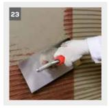
Anschließend wird das Armierungsgewebe weber.therm 310 in senkrechten oder waagerechten Bahnen mit Glätter oder Traufel faltenfrei in den Armierungsmörtel eingedrückt. Die Gewebebahnen müssen an den Stößen mind. 10 cm überlappen (Abb. 23). Das Gewebe muss anschließend in der oberen Hälfte des Armierungsmörtels liegen. Bitte beachten, dass im Eckbereich von Fenstern und anderen
