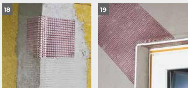
Alternativ können die Gewebeeckwinkel grob Kunststoff **weber.therm 313** mit Armierungsmörtel an den Ecken befestigt werden (**Abb. 18**). Zur Sicherung gegen Eckrisse müssen dann Armierungspfeile **weber.therm 315** oder ein zurechtgeschnittenes Gewebestück (ca. 60 x 25 cm) in die Armierungsschicht eingebettet werden (**Abb. 19**).
