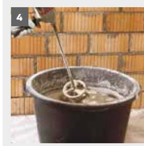
Die Platten müssen vor Feuchtigkeit geschützt gelagert werden. Durchnässte oder schadhafte Platten dürfen nicht eingebaut werden. Die Verklebung erfolgt mit dem Klebe- und Armierungsmörtel **weber.therm 300**. Bei nicht saugenden Untergründen z.B. dichter Beton oder Klinker sollte der Klebemörtel speziell **weber.therm 370**
