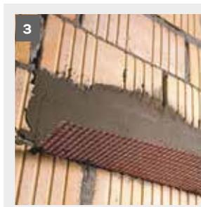
Zusätzlich kann das Profil auf ganzer Länge in Profilansetz- und Installationsmörtel **weber.mix 125** gelegt werden, was insbesondere bei unebenen Untergründen notwendig ist, um einen dichten, unteren Abschluss zu gewährleisten. Die Sockelschienen dürfen nicht pressgestoßen werden (Wärmedehnung!).
