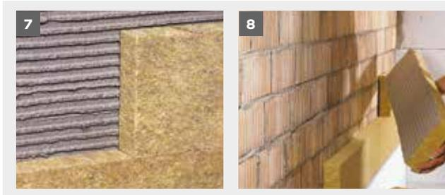
Alternativ kann der Klebemörtel auch vollflächig aufgespritzt und mit Zahnglätter (10 x 10 mm) aufgekämmt werden. Die Dämmplatten werden sofort danach (max. 10 Minuten nach dem Anspritzen des Klebemörtels, je nach Witterung und Untergrund auch weniger) in den Mörtel unter schiebenden Bewegungen eingebettet (Abb. 7). Bei Verwendung der Mineralwoll-Lamelle **weber.therm MW 041 Fassade speedy** wird der Mörtel vollflächig auf die Lamellen aufgebracht (Abb. 8).
