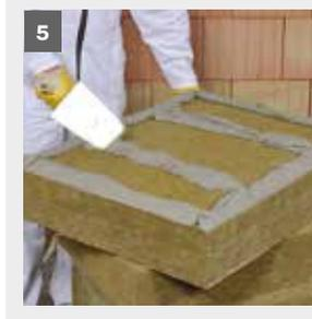
Der Mörtel ist so zu verteilen, dass nach dem Andrücken der Platte mind. 50 % der Fläche mit dem Untergrund verbunden ist.
