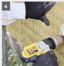
Die Platten müssen vor Feuchtigkeit geschützt gelagert werden. Durchnässte oder schadhafte Platten dürfen nicht eingebaut werden. Die Montage erfolgt mit **weber.therm Schraubdübel SRD-5** und Zusatzteiler **weber.therm VT 112 2G**. Hierbei werden die Dämmplatten anschließend horizontal verlegt. (800 mm Dimension in der Horizontalen). Nach Abschluss der Montage werden die in den
