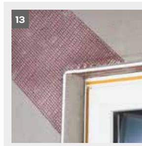
Alternativ können die Gewebbeckwinkel grob Kunststoff **weber.therm 313** mit Armierungsmörtel an den Ecken befestigt werden. Zur Sicherung gegen Eckschisse müssen dann Armierungspfeile **weber.therm 315** oder ein zurechtgeschnittenes Gewebestück (ca. 60 x 25 cm) in die Armierungsschicht eingebettet werden.
