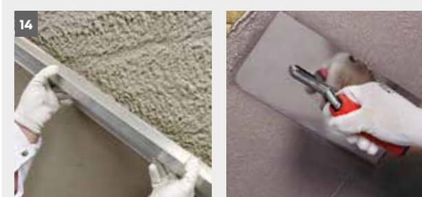
Für die Sicherstellung der Rezyklierbarkeit wird in das untere Drittel der Grundputzschicht **weber.therm 310 Armierungsgewebe grob** als Separationsgewebe eingelegt. Nach einer Standzeit von 14 Tagen wird der Armierungsmörtel **weber.therm 302** auf den **weber.therm armadura base** aufgetragen.
