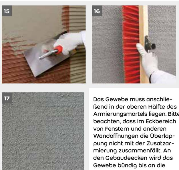
Das Gewebe muss anschließend in der oberen Hälfte des Armierungsmörtels liegen. Bitte beachten, dass im Eckbereich von Fenstern und anderen Wandöffnungen die Überlappung nicht mit der Zusatzarmierung zusammenfällt. An den Gebäudeecken wird das Gewebe bündig bis an die Ecken herangeführt.
