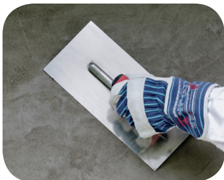
7. Auftrag der Feinspachtelung aus weber.rep R4 duo
