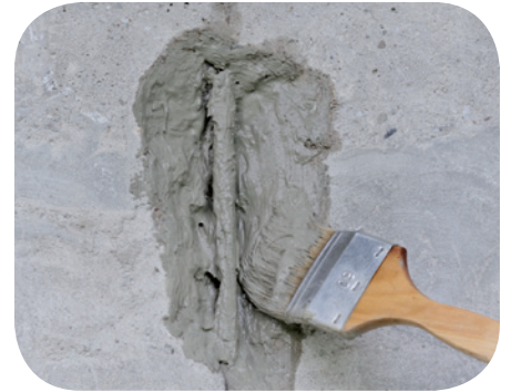
3. Auftrag der Haftbrücke, weber.rep KB duo
