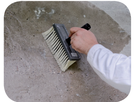
6. Vornässen vor Auftrag der Feinspachtelung
