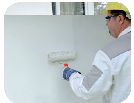
9. 2-facher Anstrich weber.tec 771 auf durchgetrocknetem Feinspachtel
