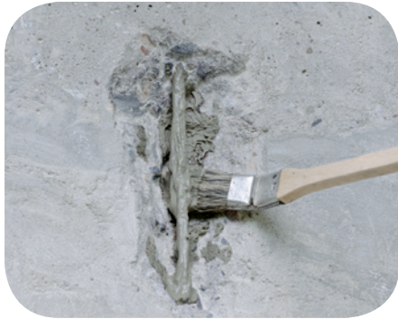
1. 2-facher Auftrag des Korrosionsschutzes, weber.rep KB duo
