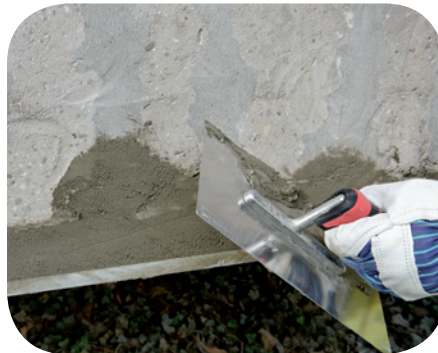
5. Auftrag des Betonersatzmörtels weber.rep R4 duo frisch in frisch auf die Haftbrücke
