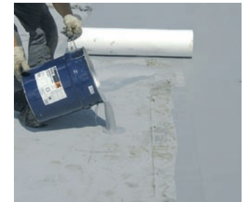
2. KEMPEROL® wird auf den Untergrund aufgebracht
