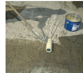
1. Untergrundvorbereitung nach Grundierungsempfehlung
