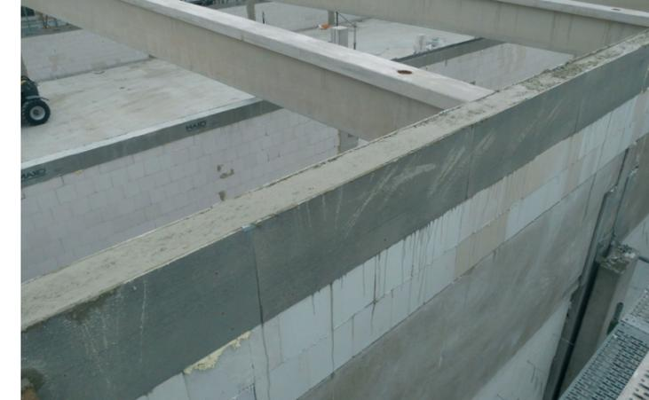
Erfahrung, Kompetenz und Weitblick von MAKO spiegeln sich auch im Bau verloreener Unterzugschalungen bei diesem Produkt deutlich wieder. MAKOSTURZ-BIG ist die passende Lösung für Unterzüge mit Breiten ab 40 cm und Höhen bis zu 100 cm, wobei Passgenauigkeit ganz im Vordergrund steht.
