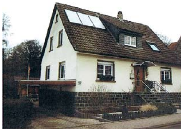
In die Jahre gekommen: Weder optisch noch bauphysikalisch entsprach dieses Gebäude den heutigen Anforderungen.
