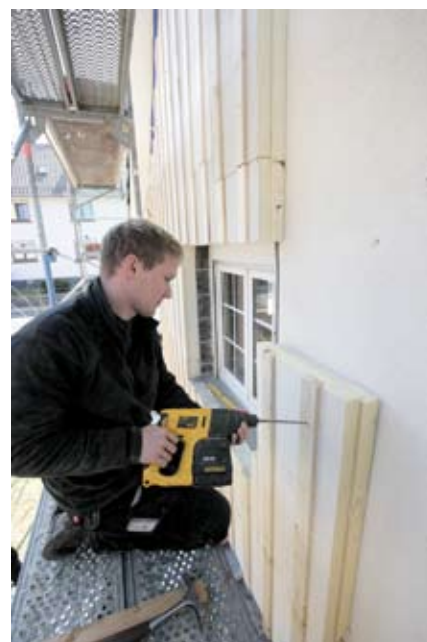
Zur Montage müssen die Holzleisten mit einem Holzbohrer vorgebohrt werden. Die Verankerungstiefe der Dübel im tragenden Bauteil beträgt mindestens 50 mm. Bauaufsichtlich zugelassene Langschaftdübel stehen für diesen Zweck zur Verfügung.
