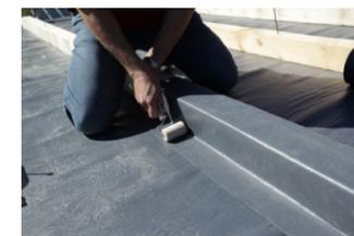
Einbinden der Konterlattungen ohne Risiko des Feuchteinschlusses möglich.
