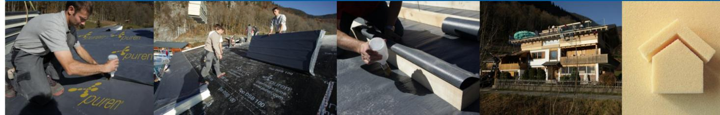
Dachaufstockung "Wohlfühlhaus Evelin": das Dach wurde mit der Hochleistungsdämmung puren PUR-Unterdach energieeffizient gedämmt und nach Ö-Norm B 4119 als regensicheres Unterdach fachgerecht ausgeführt.
