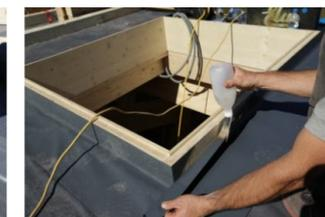
Sichere Anschlüsse mittels kalt und warm verschweißbarer High-Tech-Unterdachbahn.
