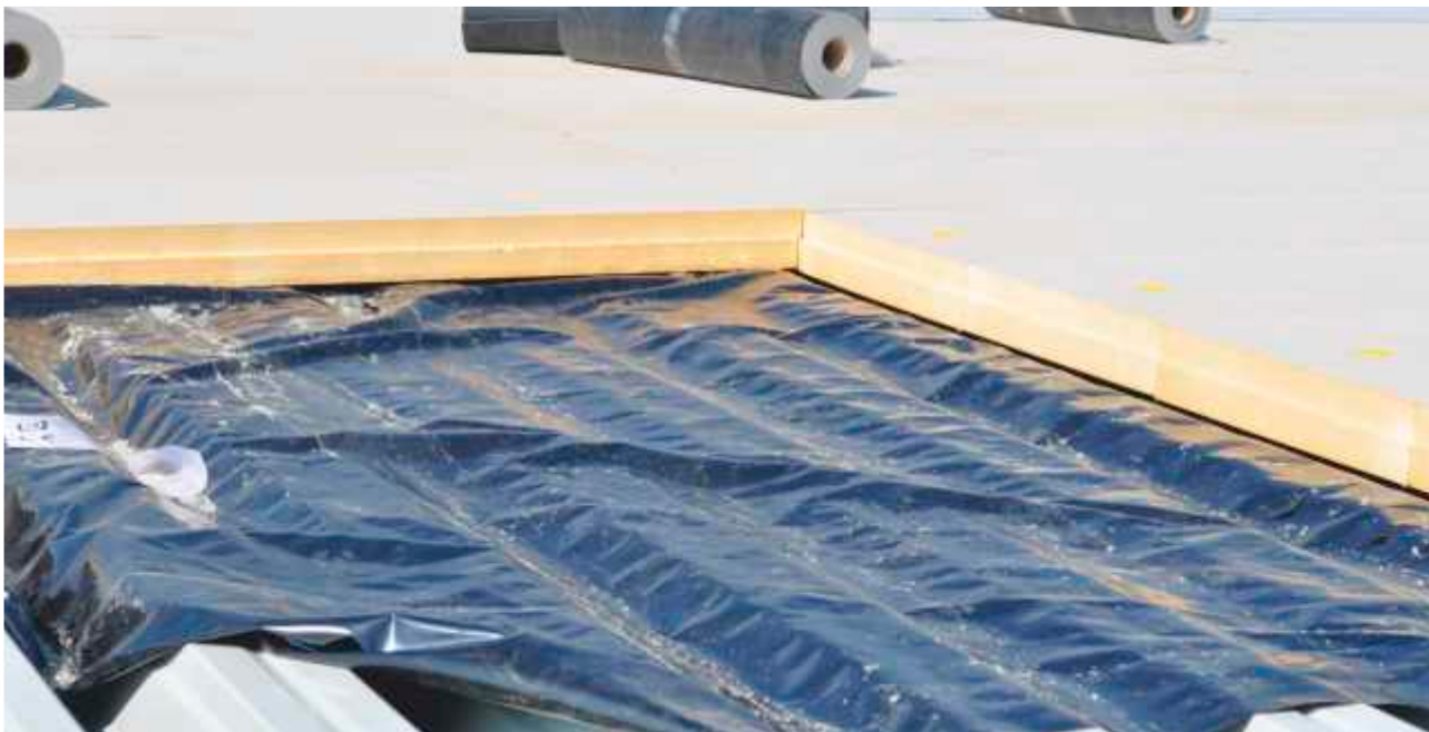
Beispiel eines Dachaufbaus, bestehend aus einer Unterkonstruktion aus Stahltrapezblech mit Trennlage, oberseitig gedämmt mit puren PU-Hartschaum, verlegt unter einer Dachbahn.
