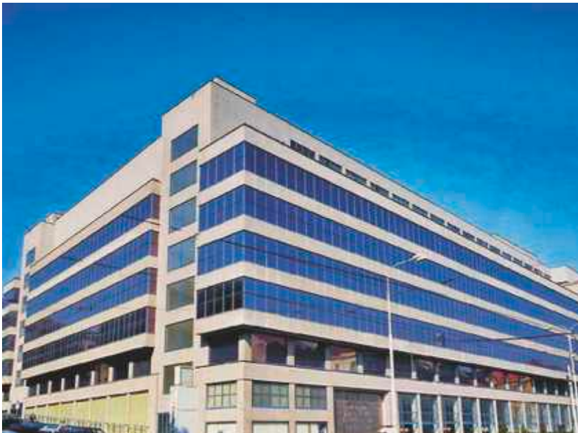
Wertvolles schützen und erhalten - die Nationalgalerie in Prag wurde mit einer Flachdachdämmung von puren zukunftsfähig saniert.
