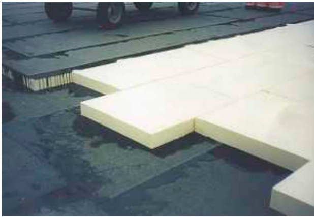
puren NE-B2 Dämmplatten ohne Deckschicht sind besonders formstabil und mit kurzfristig hoher Temperaturbelastung auch in Heißbitumen verlegbar.
