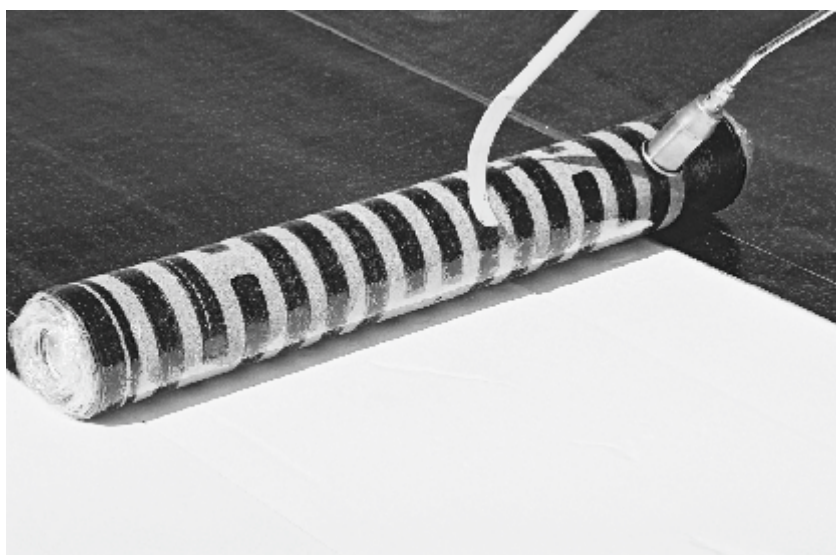
Bild: Aufschweißen der Zwischenlage
