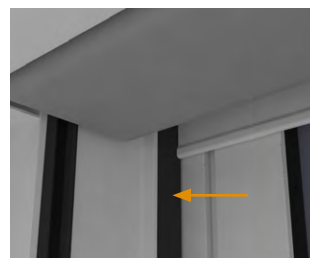
Spaltabdeckung bei Einsatz einer Führungsschiene für Multifunktion (XP-Baureihe mit Insektenschutzgitter), jedoch noch ohne Einsatz derselben
