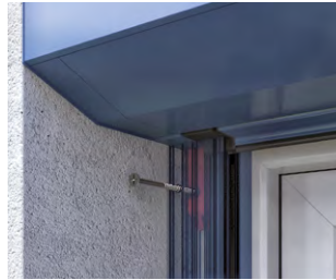
Standardbefestigung durch die Bohrung im Blendkappen-Zapfen
