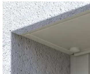
Prinzipdarstellung Friesaussparung
