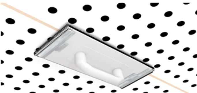
Weitergehende Beschichtungsarbeiten im System dürfen erst nach erfolgter vollständiger Trocknung der Verfugung ausgeführt werden.
