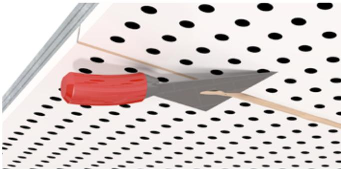
Zum Abschluss werden die gespachtelten Flächen nach Durchtrocknung eben geschliffen. Nach vollständiger Trocknung können Frieße und Anschnittflächen mit DANO® Pastös Finish flächengleich überarbeitet werden.
