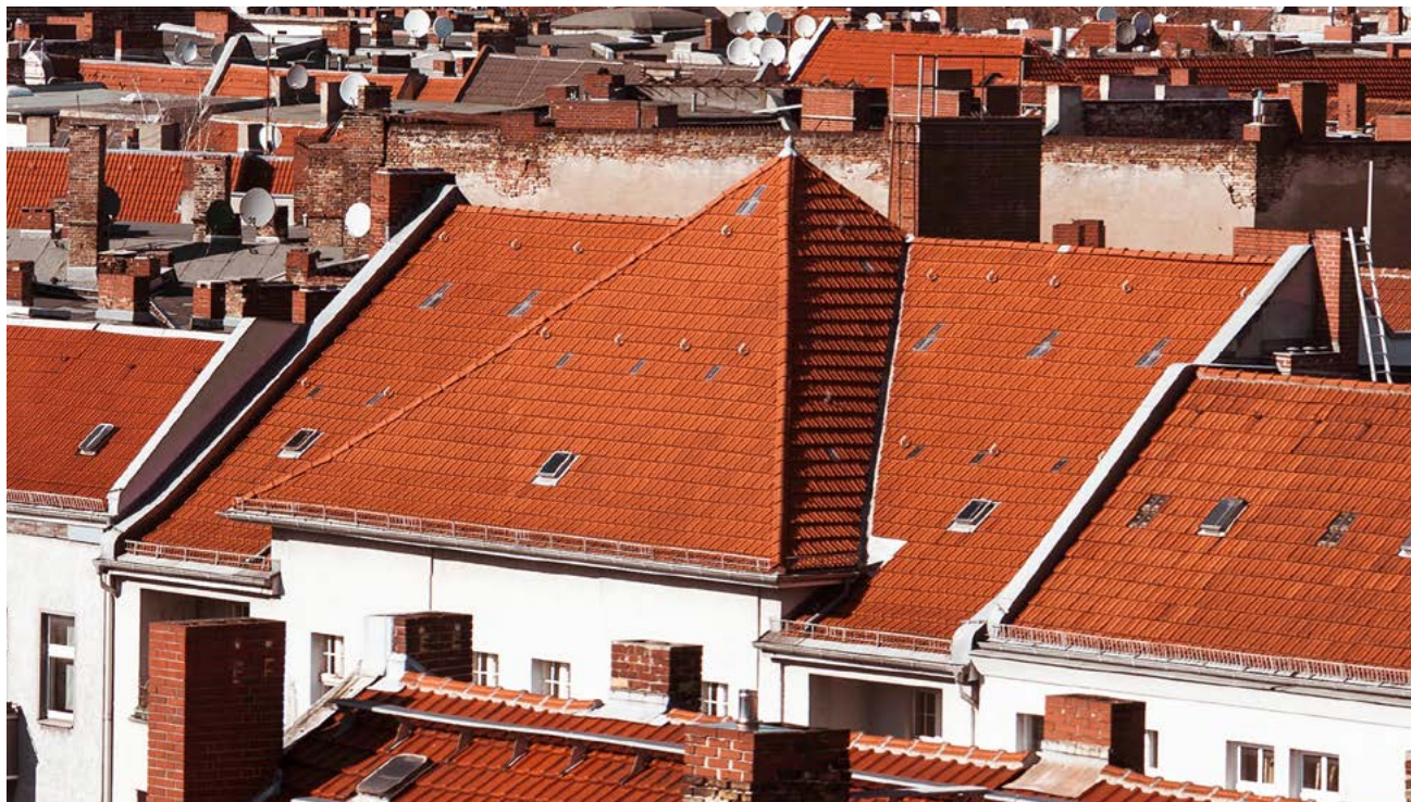
Brandwände verhindern eine Brandausbreitung
