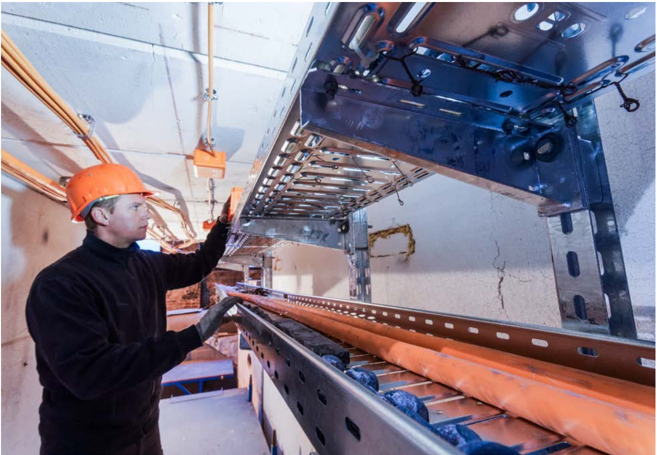
Prüfaufbau einer Funktionserhalt-Kabelanlage
