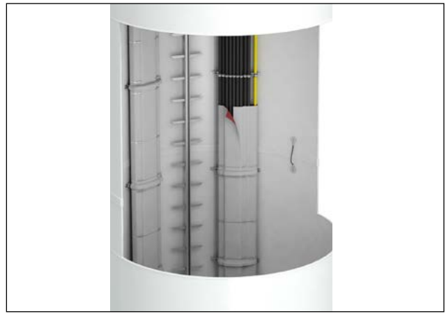
Bandagierte Steigetrasse im Turm einer Windkraftanlage
