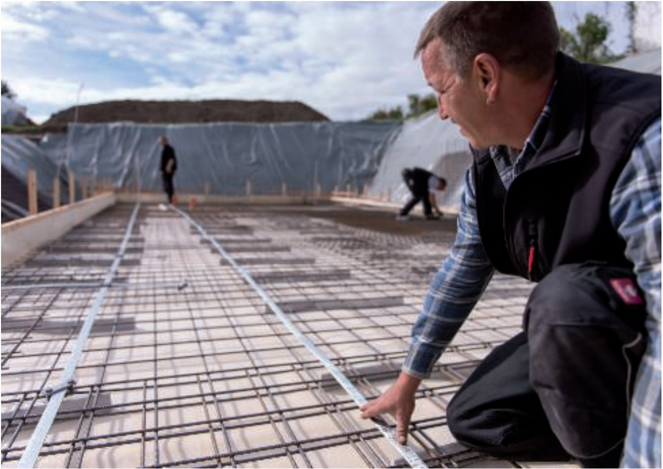
Verlegung eines Fundamenterders
