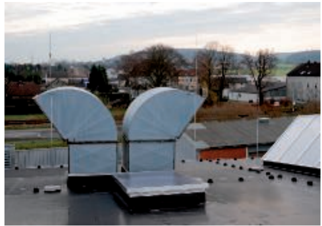
Getrenntes System mit GFK-Haltern
