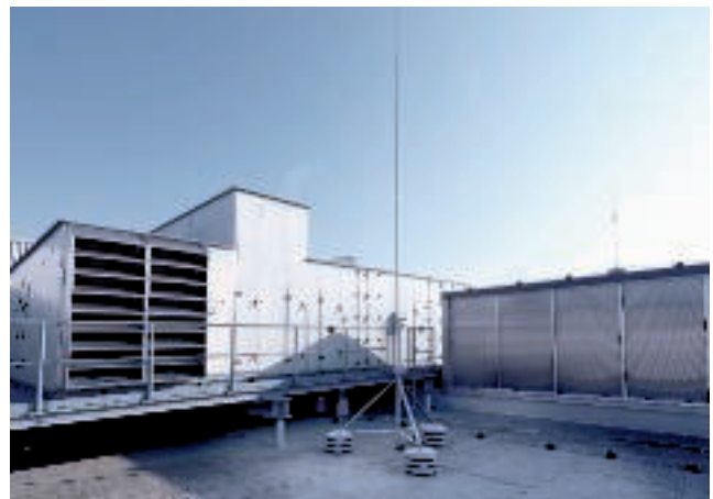
Isolierter Blitzschutz mit isFang
