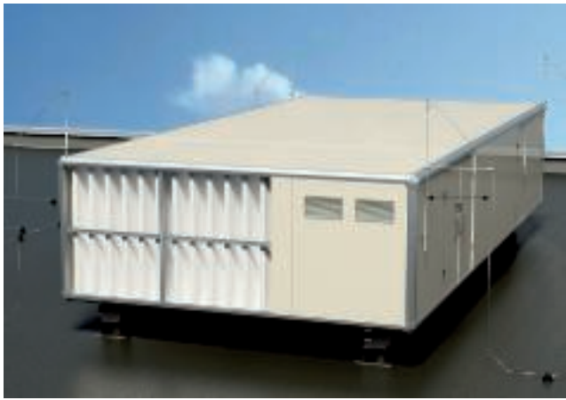
Isolierte Fangeinrichtung mit Trennungsabstand (s)
