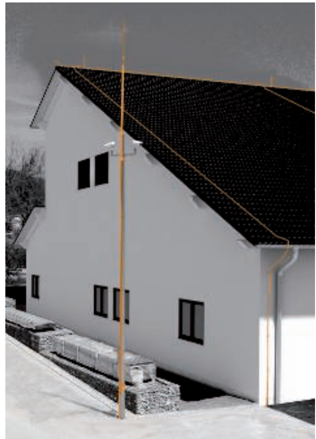
Überwachungskamera mit isCon®-Ableitung
