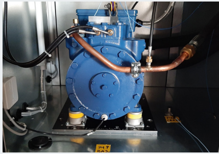
Lagerung eines Hubkolbenkompressors mit Isotop® DZE Mini
