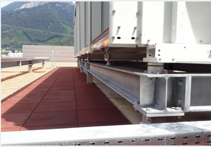
Rückkühler mit Isotop® DZE gegen hohe Windlasten
