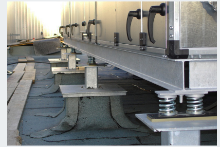
Pumpenlagerung mit zusätzlicher Masse RLT auf Dach installiert
