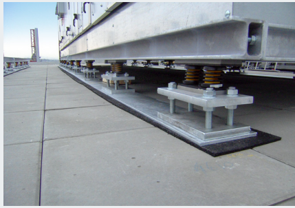
Auf-Dach-Installation einer RLT-Anlage mit höheren Windlasten
