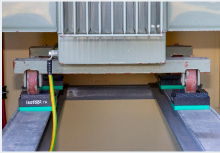
Schwingungsentkoppelte Lagerung eines Verteiltransformators
