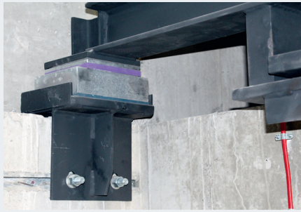
Lagerung einer Aufzugsanlage mit Seilträger im Schachtkopf
