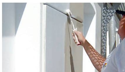
Nun wird die komplette Fläche grundiert.
