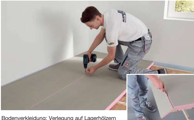
Bodenverkleidung: Verlegung auf Lagerhölzern
