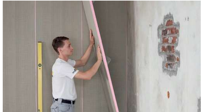
Wandflächen: Ausgleich von Altbauwänden
