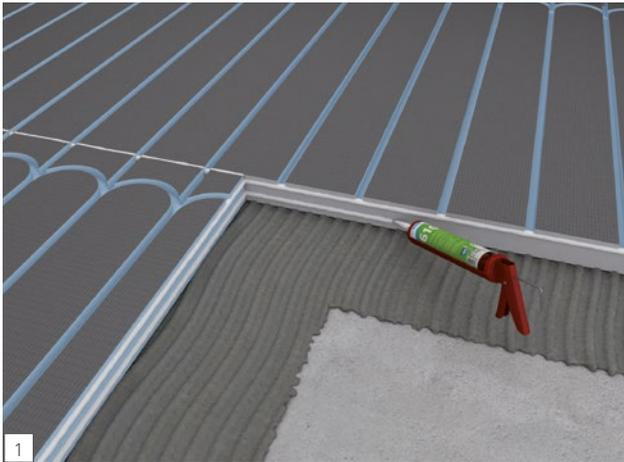
wedi PreLine wird vollflächig mit einem Dünnbettmörtel (Empfehlung: wedi 320 Fliesenkleber universell) auf dem Untergrund verlegt und ausgerichtet. Im Nassbereich sind die Bauplattenstöße vollflächig und durchgängig mit wedi 610 Kleb- und Dichtstoff (Empfehlung: eine Raupe wedi 610 unterhalb der Fräsung und eine Raupe auf Höhe der Fräsung) zu verkleben und abzudichten.
