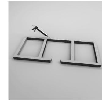
4 Unterbau auf dem Boden verkleben und Kleber für die Wanne auftragen.
