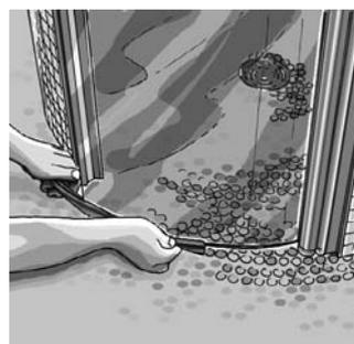
Montage unterer Spritzschutz Tür öffnen und unteres Spritzschutzprofil auf Glastür aufziehen.
