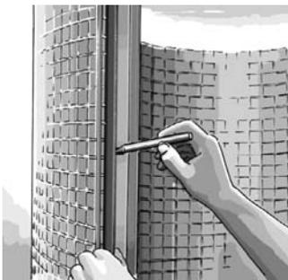
Montage Wandanschlussprofile Wandanschlussprofil mittig an verflieste Laibung anhalten und vorgegebene Bohrungen auf Fliesen anzeichnen.
