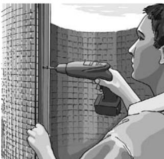
Wandanschlussprofil mit beiliegenden Bohrschrauben auf verfliester Türleibung befestigen.
