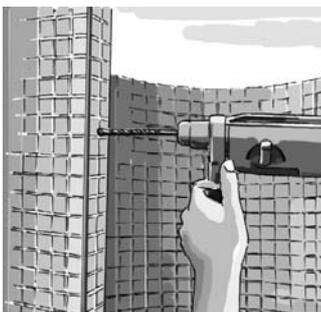
Fliesen mit 5 mm Steinbohrer -ohne Schlagbohrereinstellung- an markierten Stellen vorbohren (Unterhalb der Fliese ist die Duschtrennwand mit einem U- Profil verstärkt. Profil muss nicht vorgebohrt werden!).
