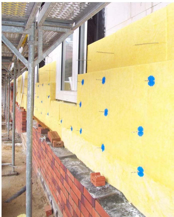
Detail Wandaufbau mit Dämmung
