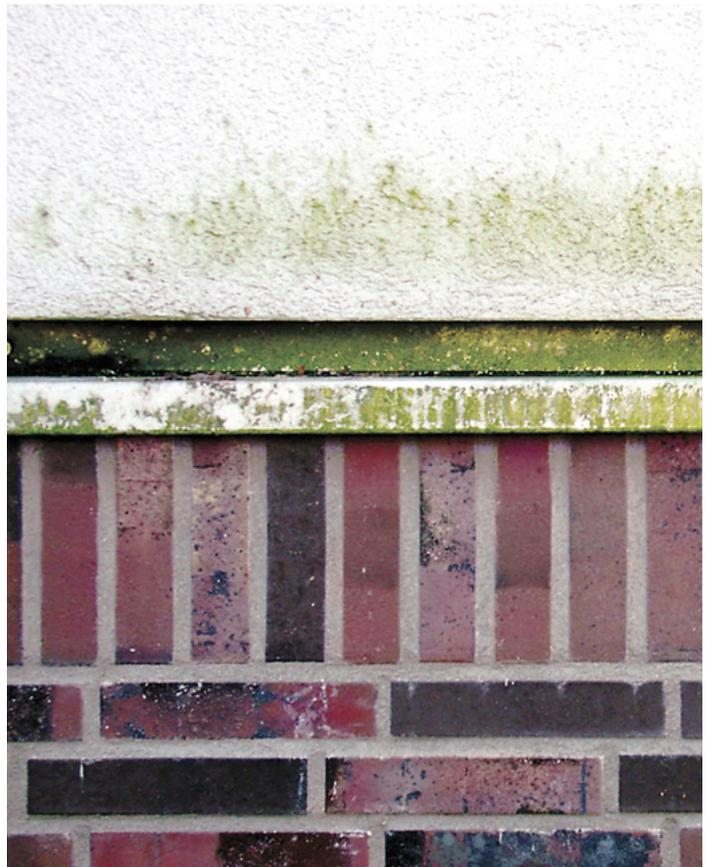
*Algenwachstum und Verfärbungen auf Putzoberflächen bei hochwärmegeprägten Bauweisen. Beim anschließenden Klinkermauerwerk ist kein Algenwachstum vorhanden.*
