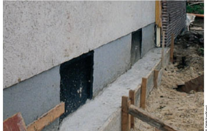
Bild 1: Zur Aufstellung der Verblendschale kann die Anlegung eines Streifenfundamentes erforderlich sein ...
