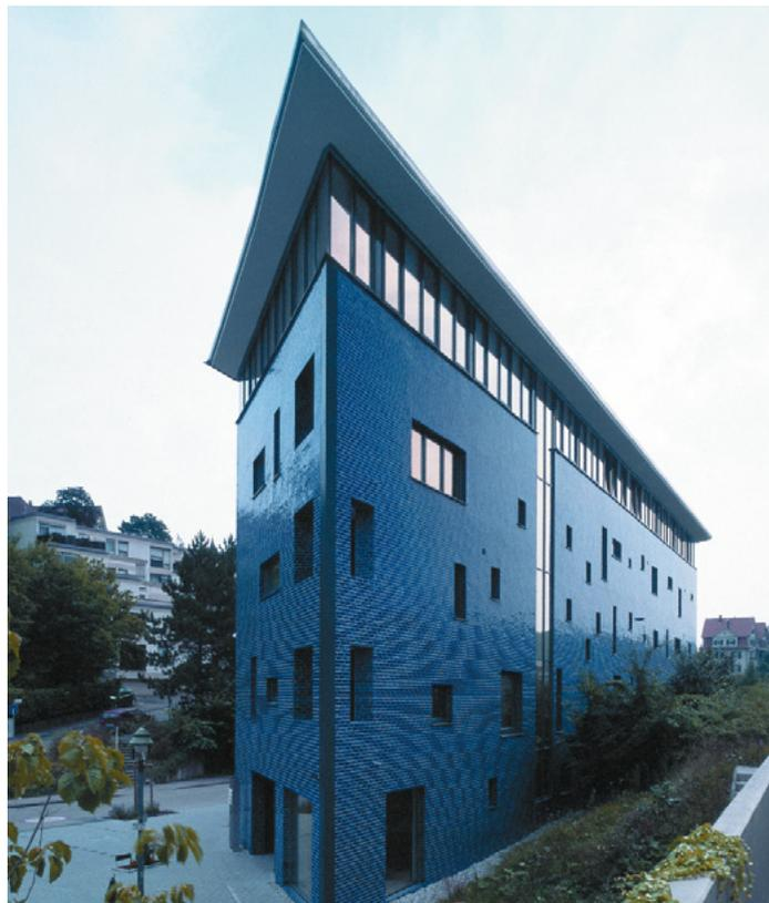
Bild 10: Hochwertige Klinkerriemchen ermöglichen die Realisierung anspruchsvoller Fassadenkonzepte.
