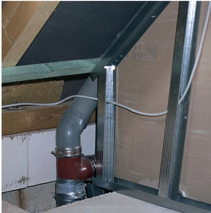
Foto 7: Hohlkammersystem, die luftdichte Schicht darf nicht an diese Wand angeschlossen werden, sondern muss in der Ebene des Daches ohne Unterbrechung durchlaufen.
