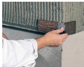
Bild 14: Auch werden an allen Gebäudeecken Winkelriemchen eingesetzt.
