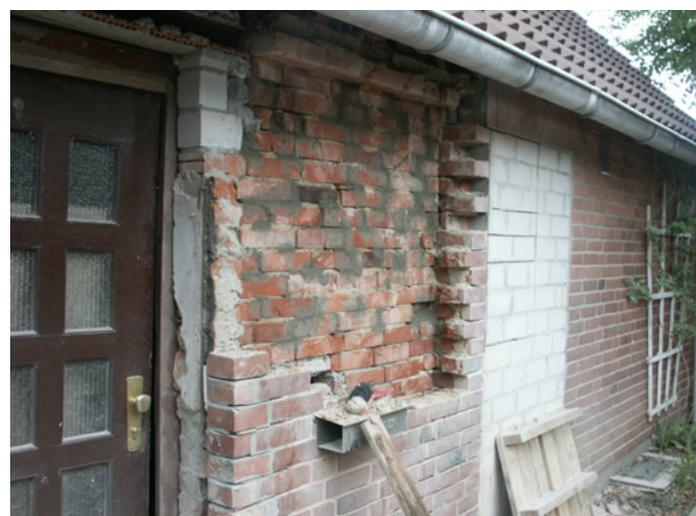
Abriss der alten Vormauerschale, alle Abbildungen zu diesem Projekt
