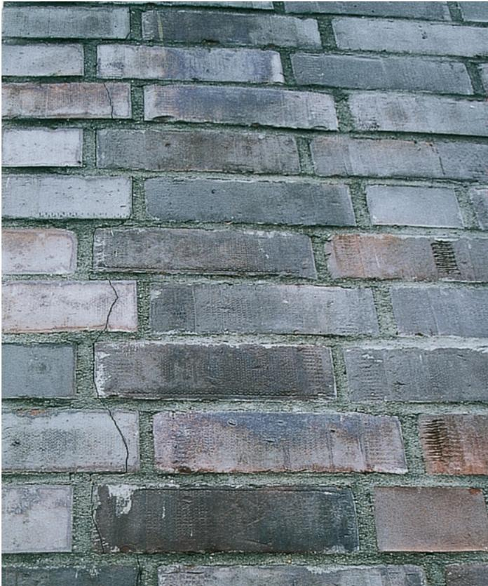
Werden keine Dehnungsfugen an den Ecken vorgesehen, entstehen Risse
