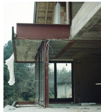
Foto 2: Massive Wärmebrückenwirkung, Kragplatte aus Stahlträger und Stahlbeton ohne thermische Trennung.
