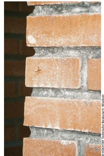
Nicht vollständig gefüllte Fugen verursachen verstärkten Witterungsangriff, mögliche Folgen: Mörtelzerstörung, Algenbewuchs
