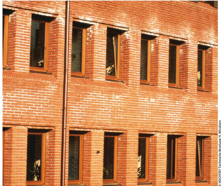
Unzureichender konstruktiver Feuchteschutz führt zu Durchfeuchtungen und Ausblühungen, hier: tiefausgerundete Fugen, fehlende Tropfkante am Sturz, Fensterbänke aus Rollschichten ohne Überstände
