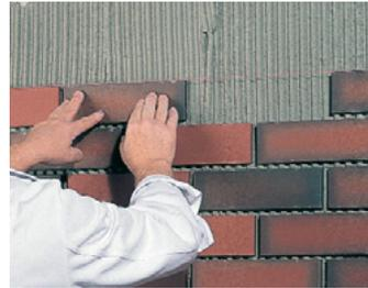
Bild 12: Die Riemchen werden im Floating-Buttering-Verfahren verklebt.
