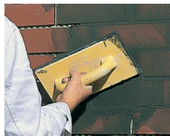
Bild 16: Insbesondere bei Klinkerriemchen mit sehr niedriger Wasseraufnahmefähigkeit besteht die Möglichkeit, die Fugen mit Schlämmörtel zu schließen.
