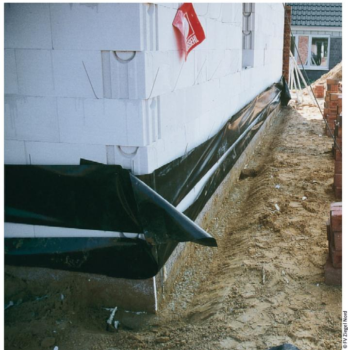
Zweifache Sperrschicht einer zweischaligen Wand bei erdberührendem Mauerwerk
