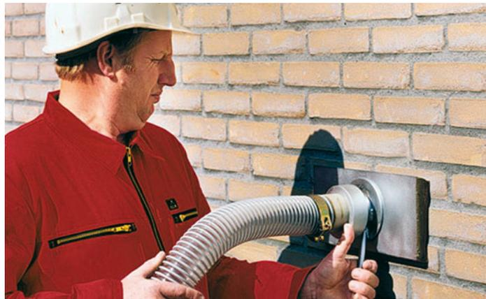
Bild 6: Die Dämmung wird als loses Granulat in die Hohlchicht eingeblasen.
