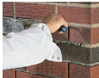
Bild 15: Die Verfugung erfolgt wie beim Verblendmauerwerk mit einem Fugeisen.
