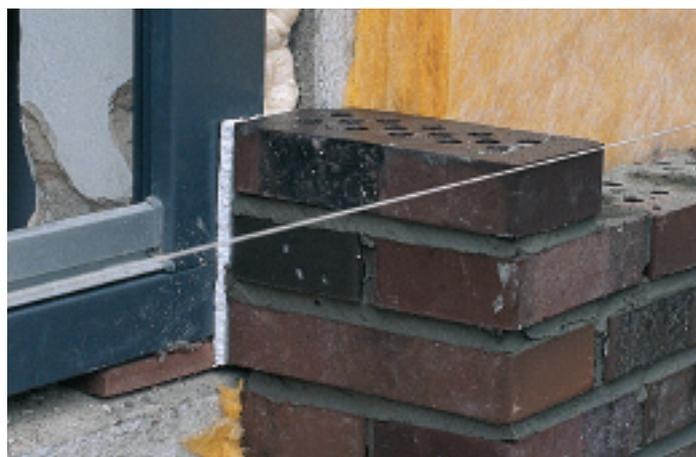
Bild 5: An allen Kontaktflächen zwischen den beiden Schalen sind ausreichend dicke Dämmstreifen entsprechend der DIN 4108 Bbl 2 einzulegen.
