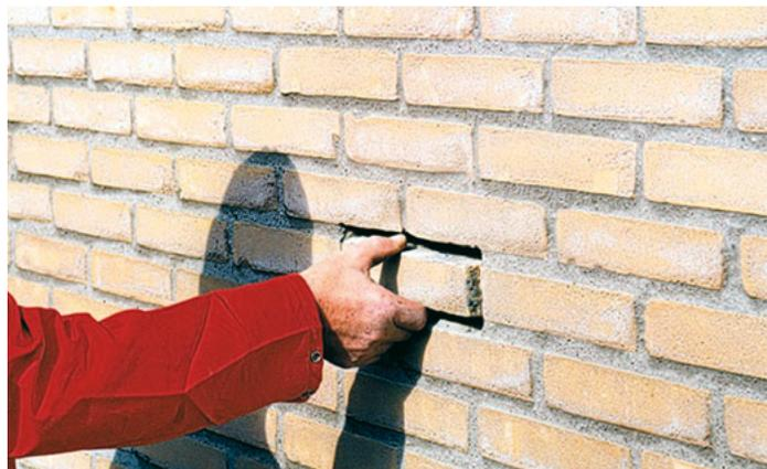
Bild 7: Nach Abschluss der Arbeiten wird der Verblendstein wieder eingesetzt und vermörtelt.
