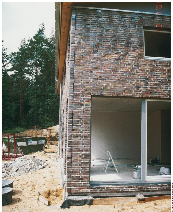
*Beispielhafte Detaillösungen: Feuchtigkeitssperre an Sockel und Terrassenstürze, Dehnungsfuge auf wetter-*
