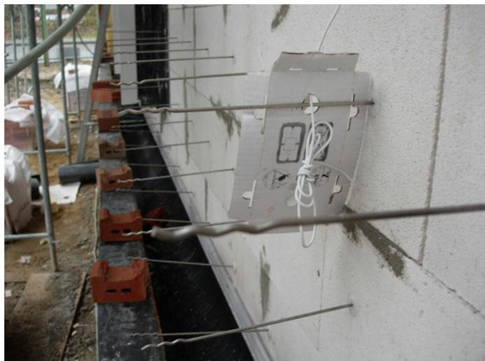
Detail Wandaufbau Maueranker
