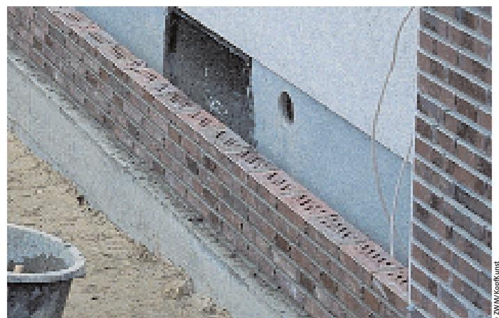
Bild 3: Für die Aufmauerung der Verblendschale sind die Bestimmungen der DIN 1053-1 maßgebend.
