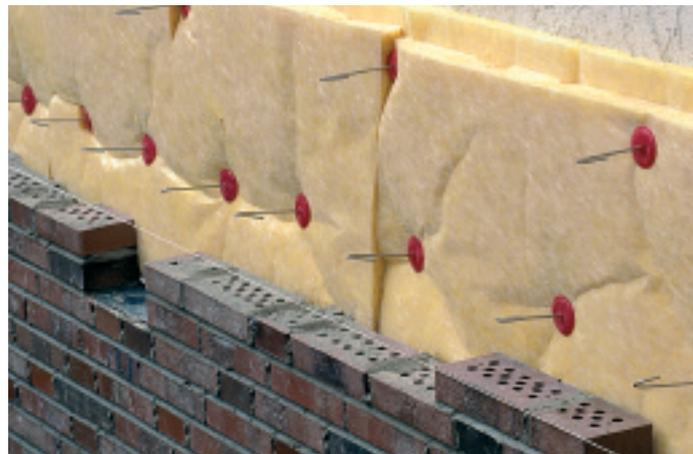
Bild 4: Weiche Dämmstoffe sind für Sanierungsmaßnahmen besser geeignet als harte Platten, da sie flexibel sind und eine hohlraumfreie Verarbeitung bei unebenen Untergründen ermöglichen.
