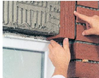
Bild 13: Mit Winkelriemchen für die Stürze wird das beabsichtigte Bild einer gemauerten Wand vermittelt.
