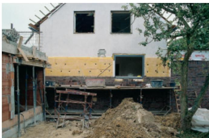
Zwischen den Bauteilen Giebelwand/seitlicher Anbau sind Dehnungsfugen anzuordnen.
