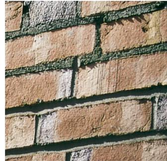
Als Nachteil beim „Fugenglattstrich“ gilt es allerdings, dass der Zeitpunkt des Glattstreichens der Fugen für die gesamte Fassade genau abgestimmt werden muss, um eine völlig gleichmäßige Fugenfarbe erzielen zu können. Selbst geringe Schwankungen in der Temperatur und/oder Luftfeuchtigkeit beim Verstreichen der Fugen machen sich später durch unterschiedliche Helligkeit der Fugenfarbe bemerkbar.
