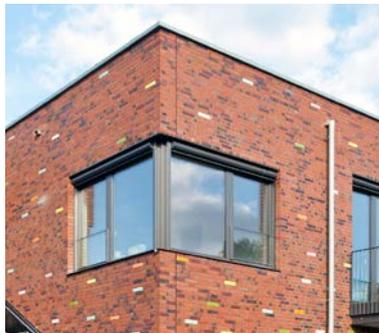
▲ Vertikale Dehnungsfuge im Eckbereich
