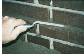
Für eine dichte Fuge ist entscheidend, dass der Mörtel fest in die Fuge eingedrückt und verdichtet wird. Daher sollte das Fugeisen auf keinen Fall breiter als die Fuge selbst sein.
