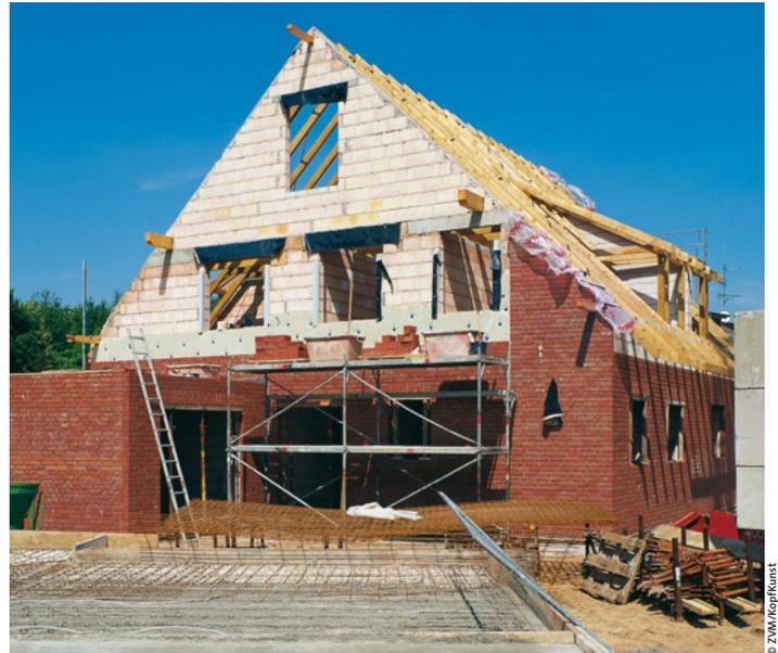
zu 15%. Bei einem Hochlochziegel ergeben sich allein durch die Formatwahl von 2 DF auf 16 DF Arbeitszeitunterschiede von 2,2 Stunden pro m<sup>3</sup> Mauerwerk (von 5,0 auf 2,8). Die Steinzahl reduziert sich von 263 auf 32 Stück / m<sup>3</sup> und der Mörtelbedarf von 260 auf 140 Liter / m<sup>3</sup>.
