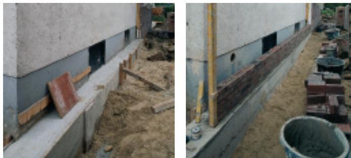
Auflagerung der Vorsatzschale auf einem zusätzlichen Fundament
