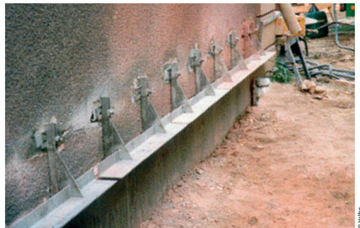
Bild 2: ... oder eine Abfangkonsole für eine nachträgliche Verblendung.
