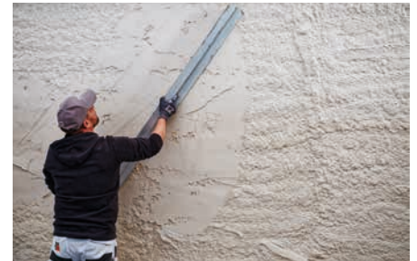
3. Die Putzfläche wird gleichmäßig abgerichtet.
