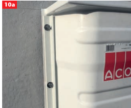
7 Obere Bohrungen setzen und Dübel mit Distanzscheibe einstecken
