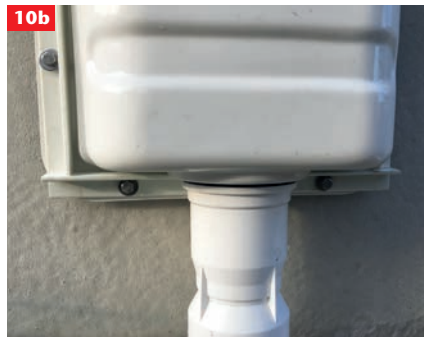
10b Lüftungsschacht inklusive der Montageschienen montieren. Schrauben durch Dichtungsband schrauben
