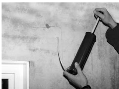
4. Bohrlöcher reinigen.
