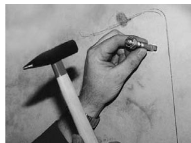
5. Die beiden oberen Schwerlastdübel einschlagen.
