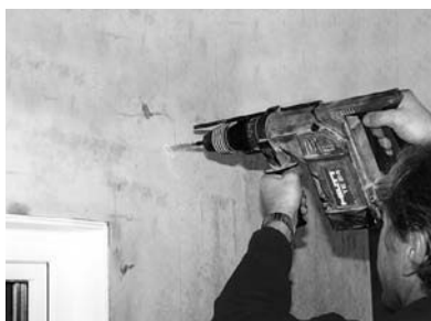
3. Die beiden obersten Löcher mit Tiefenanschlag (7 cm) bohren. Achtung: nicht zu tief bohren!
