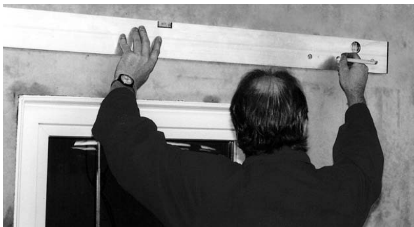
2. Die Lage des Lichtschachtes bestimmen (Oberkante Lichtschacht, Mitte Fenster) und mit der Montagehilfe für Lichtschächte die beiden obersten Löcher anzeichnen. (OK Montagehilfe = OK Lichtschacht) Den Lichtschacht anhalten und die Kontur grob mit dem Bleistift markieren.
