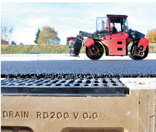
Entwässerung von offenporigem Asphalt
