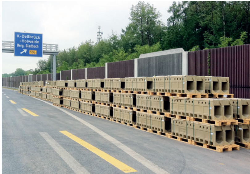
ACO DRAIN® Monoblock RD 300 DF für den Ausbau der A3
