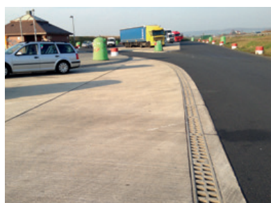
ACO DRAIN® Monoblock RD 200 V an einer Autobahnraststätte
