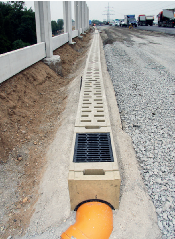
ACO DRAIN® Monoblock RD 300 während des Einbaus an der A3
