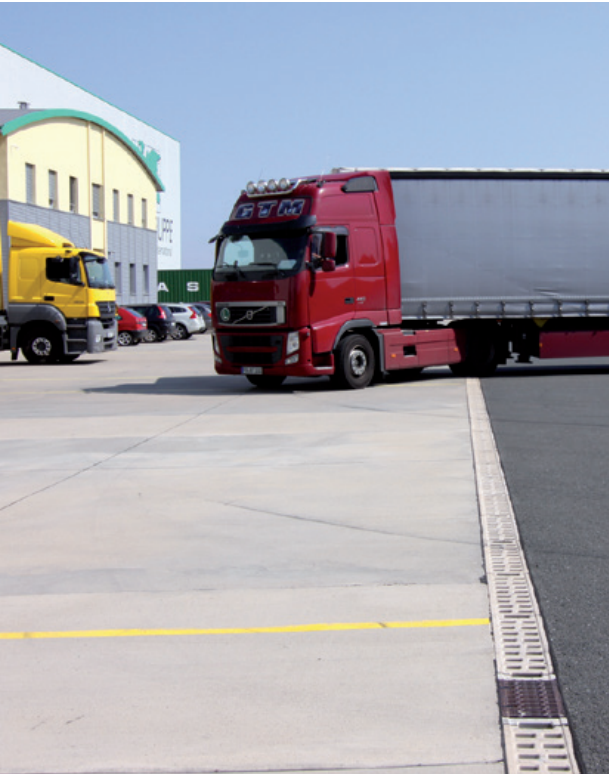
ACO DRAIN® Monoblock RD 200 V an einem Logistikzentrum
