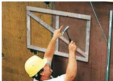
3. Stützkreuz auf der Schalung befestigen.
