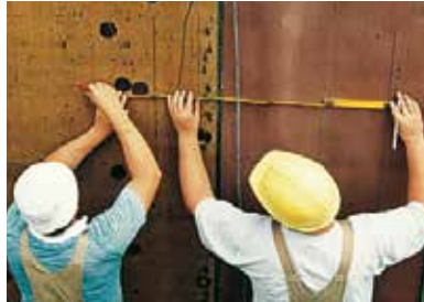
1. Leibungsfenster/Stützkreuz einmessen.
