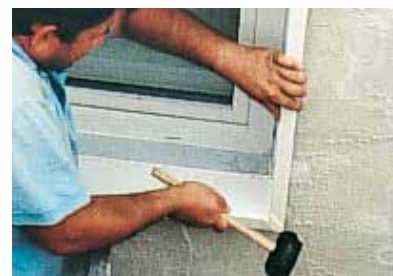
4. Durch Einschlagen in die Nut befestigen (z. B. Gummihammer). Abdichtung zwischen Dämmungsanschlussprofil und Fassade kann mit handelsüblichen Dichtstoffen erfolgen.
