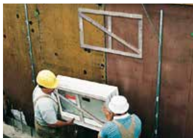
4. ACO Therm® Leibungsfenster auf das befestigte Stützkreuz stülpen und mit den seitlich angebrachten Lochbändern sichern.
