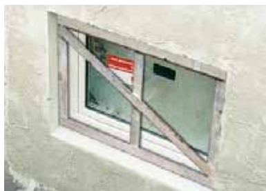
5. Die Stützkreuze verbleiben bis zum Abschluss der Rohbauphase zum Schutz vor Beschädigungen in dem Leibungsfenster.
