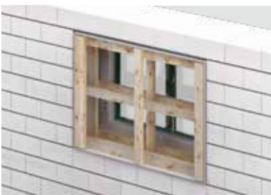
4. Aussteifungen erst nach Erhärten des Mörtels entfernen.
