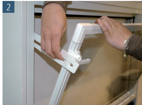
2 Die Scheren müssen zum Einsetzen des Kippflügels leicht auseinander gezogen und über den Führungsstift gedrückt werden
