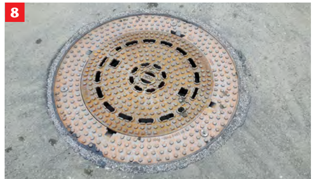
Die Abdeckung kann sofort für den Verkehr freigegeben werden
