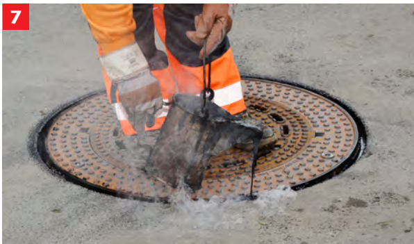
Die Anschlussfuge dauerelastisch vergießen
