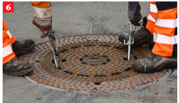
Nach dem Entfernen aller Einbauhilfen den Deckel einlegen
