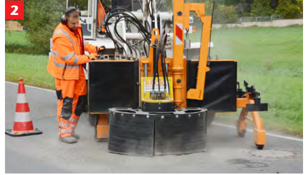
Schadhafte Abdeckung ausbohren
