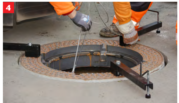
Beguplan Abdeckung einsetzen und auf Höhe ausrichten
