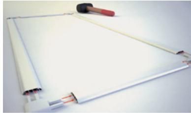
5. Stecken Sie den Rahmen zuerst per Hand zusammen. Anschließend wird er mit leichten Schlägen fixiert. Dafür eignet sich ein Gummihammer
