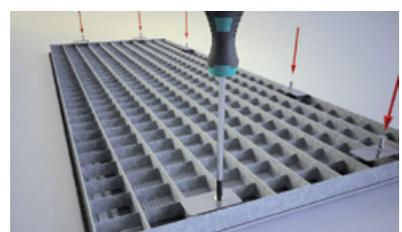
11. Je nach Art des Rostes wählen Sie zur Befestigung der Montageplatten entweder die Hülsenmuttern oder die Sechskantmuttern. Anschließend ziehen Sie sie fest an
