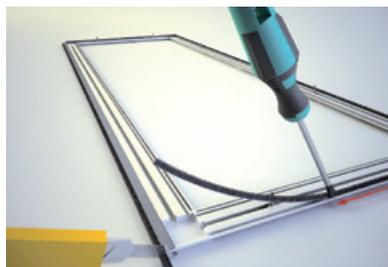
8. Schneiden Sie die Bürstendichtungen auf die jeweilige Länge. Stecken Sie die Dichtungen einseitig in die Nut und drücken Sie danach mit einem Schraubenzieher die Bürstendichtung vollständig in die Nut ein. Anschließend schieben Sie ggf. ein Stück Bürstendichtung in das Wandanschlussprofil
