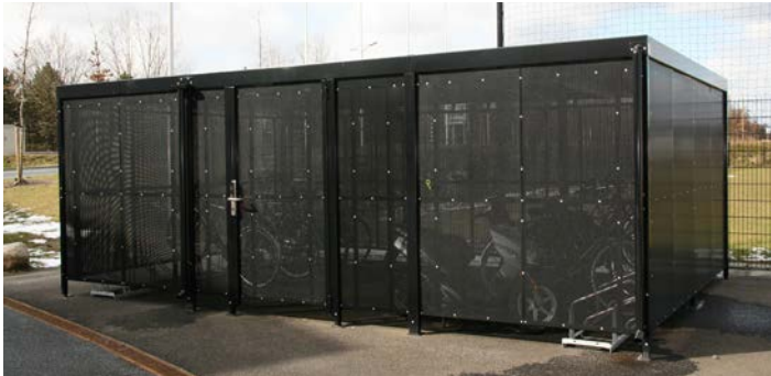
Wände verkleidet mit Lochblech, komplett pulverbeschichtet
