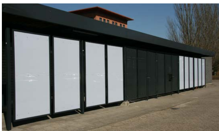
Wände verkleidet mit opalem Polycarbonat und Türen mit Lochblech in RAL 7016
