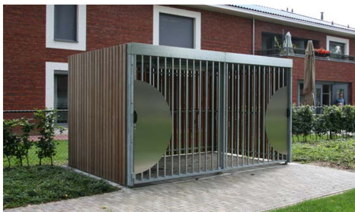
Seitenwände und Rückwand verkleidet mit vertikalen Latten und 2 Schiebetüren als Vorderwand mit Stäben
