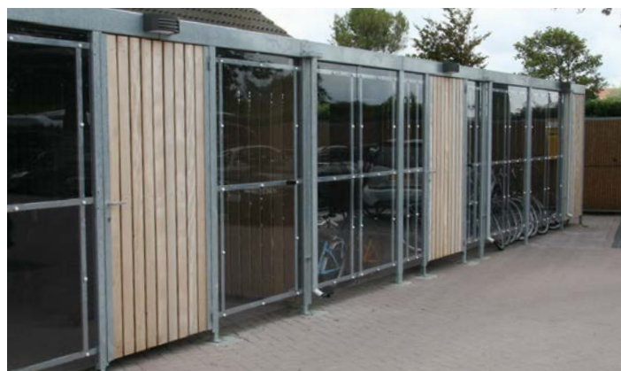
Seitenwände, Rückwand und Türen verkleidet mit offenen vertikalen Latten, Vorderwand mit glasklarem Polycarbonat
