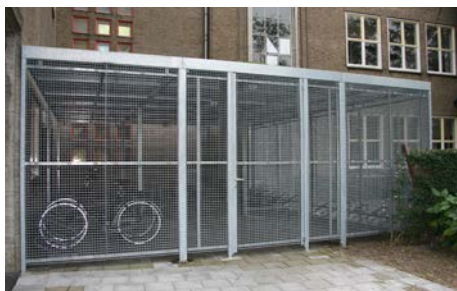
Wände verkleidet mit Pressgitter
