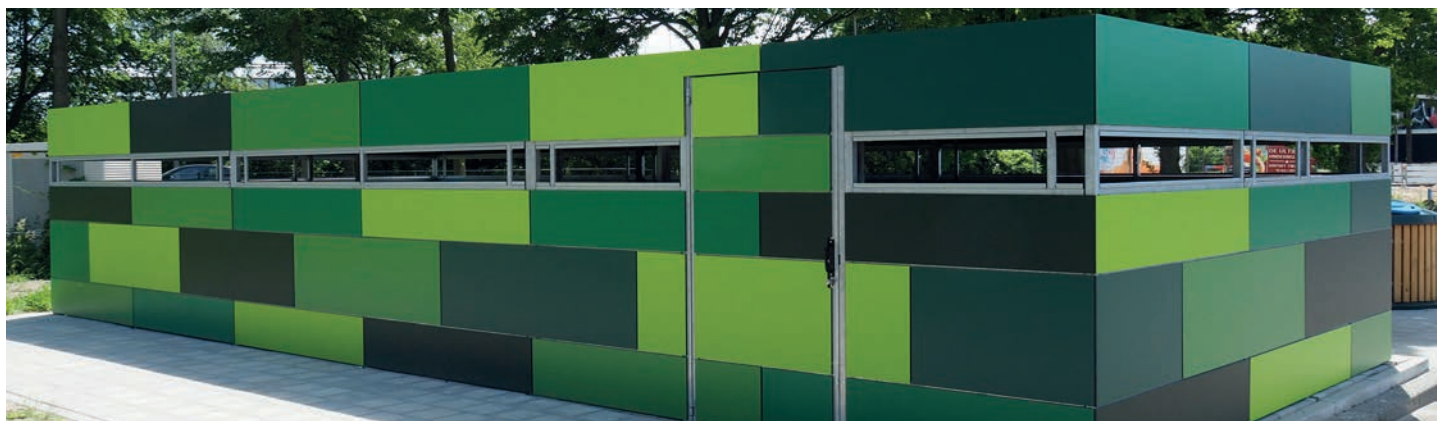
Wände mit Trespa-Platten verkleidet
