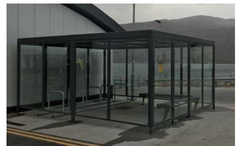
Wände verkleidet mit Sicherheitsglas
