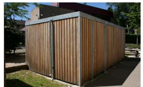
Wände verkleidet mit offenen vertikalen Latten
