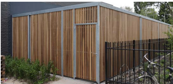
Wändverkleidung aus offenen, vertikalen Latten
