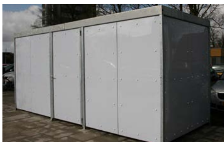
Wände verkleidet mit opalem Polycarbonat
