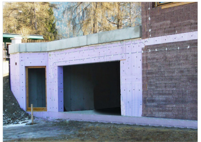
Wärmebrückendämmung mit JACKODUR® Gefiniert
