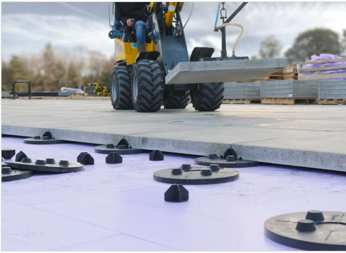
Umkehrdach mit JACKODUR®
