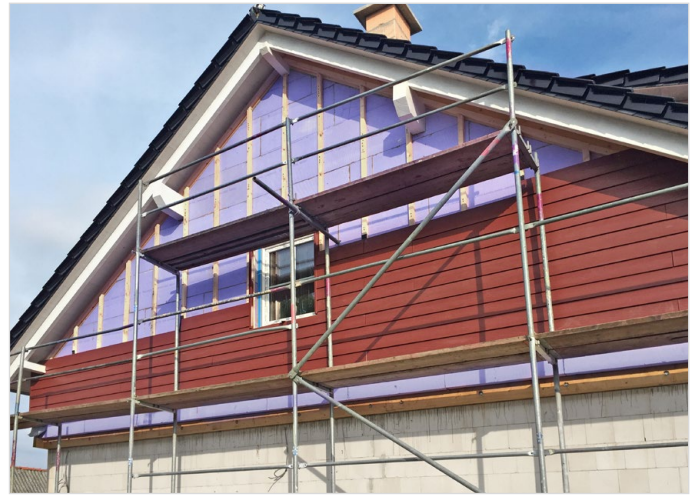
Dämmung hinter Verkleidung mit JACKODUR®
