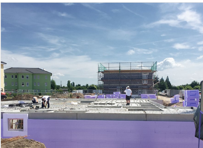
Perimeterdämmung mit JACKODUR®
