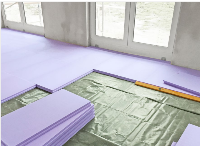
Dämmung unter Industrieestrich mit JACKODUR®
