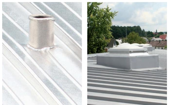
Sehr wichtig ist dabei, bei zweischaligen, wärmegeprägten Dächern, der diffusionsdichte Anschluss der Dampfsperre an die Durchdringung sowie die Vermeidung von Kältebrücken. Beachten Sie ganz besonders die Verarbeitung bzw. Verbindung der Bleche untereinander. Für den Fall, dass geschweißt werden muss sind die Schweißstellen zu säubern, insbesondere bei beschichtetem Material ist die Farbe ca. 50 mm beidseits der Schweißnaht zu entfernen und später mit Ausbesserungslack wieder zu beschichten.
