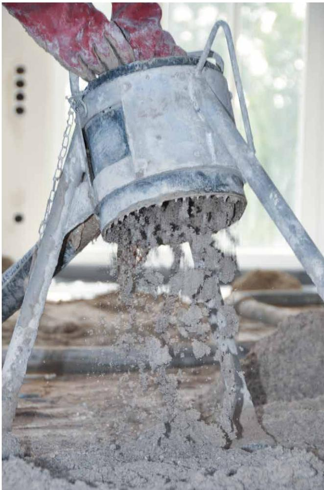
Calciumsulfatgebundene Estriche dürfen keiner dauernden Feuchtigkeitsbeanspruchung ausgesetzt werden. Bereiche im Estrich, in denen z.B. durch Dampfdiffusion mit Feuchtigkeitsanreicherung zu rechnen ist, müssen durch eine Dampfsperre geschützt werden. Eine solche Maßnahme ist vom Planverfasser der Bauwerksplanung festzulegen (DIN 18560).
