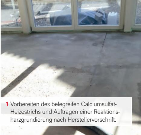
**1** Vorbereiten des belegreifen Calciumsulfat-Heizestrichs und Auftragen einer Reaktionsharzgrundierung nach Herstellervorschrift.
