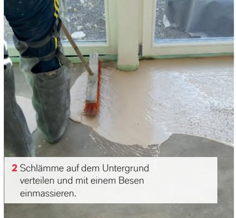
**2** Schlämme auf dem Untergrund verteilen und mit einem Besen einmassieren.
