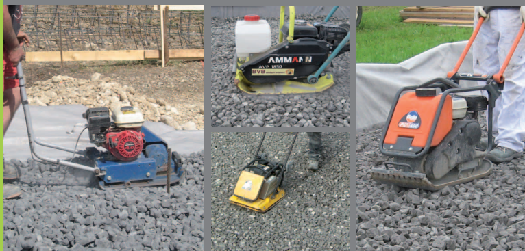
leichte Vibrations-Platte mit starkem Vortrieb
