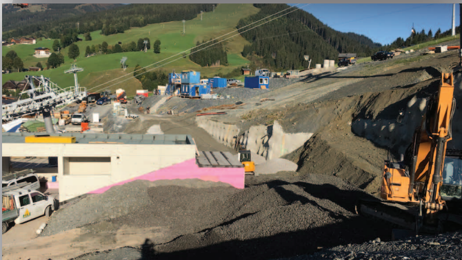
10 EUB Kohlmaibahn: © Saalbacher Bergbahnen GmbH, GEOCELL®
