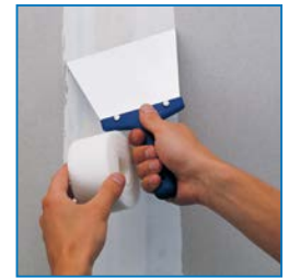
Spachteln mit Rigips-Bewehrungsstreifen
