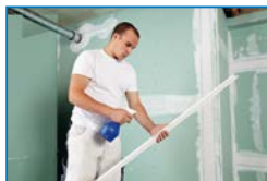
Einsprühen mit Wasser
