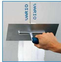
Spachteln ohne Rigips-Bewehrungsstreifen
