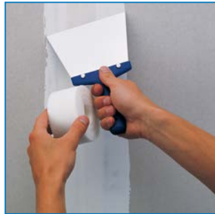
SUPER-System mit Glasfaserbewehrungsstreifen
