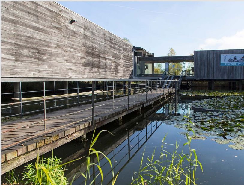
LINITHERM PGV Gefälledämmung mit Kehle für Außenentwässerung, Federseemuseum Bad Buchau
