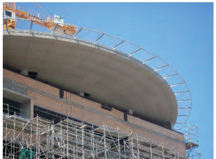
Spanien: Verkleidung mit AMROC-Panel B1 (ungeschliffen)
