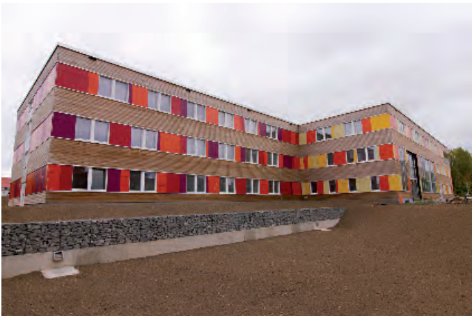
Deutschland, Halle/Saale: Grundschule mit AMROC-Color Finish-Fassade
