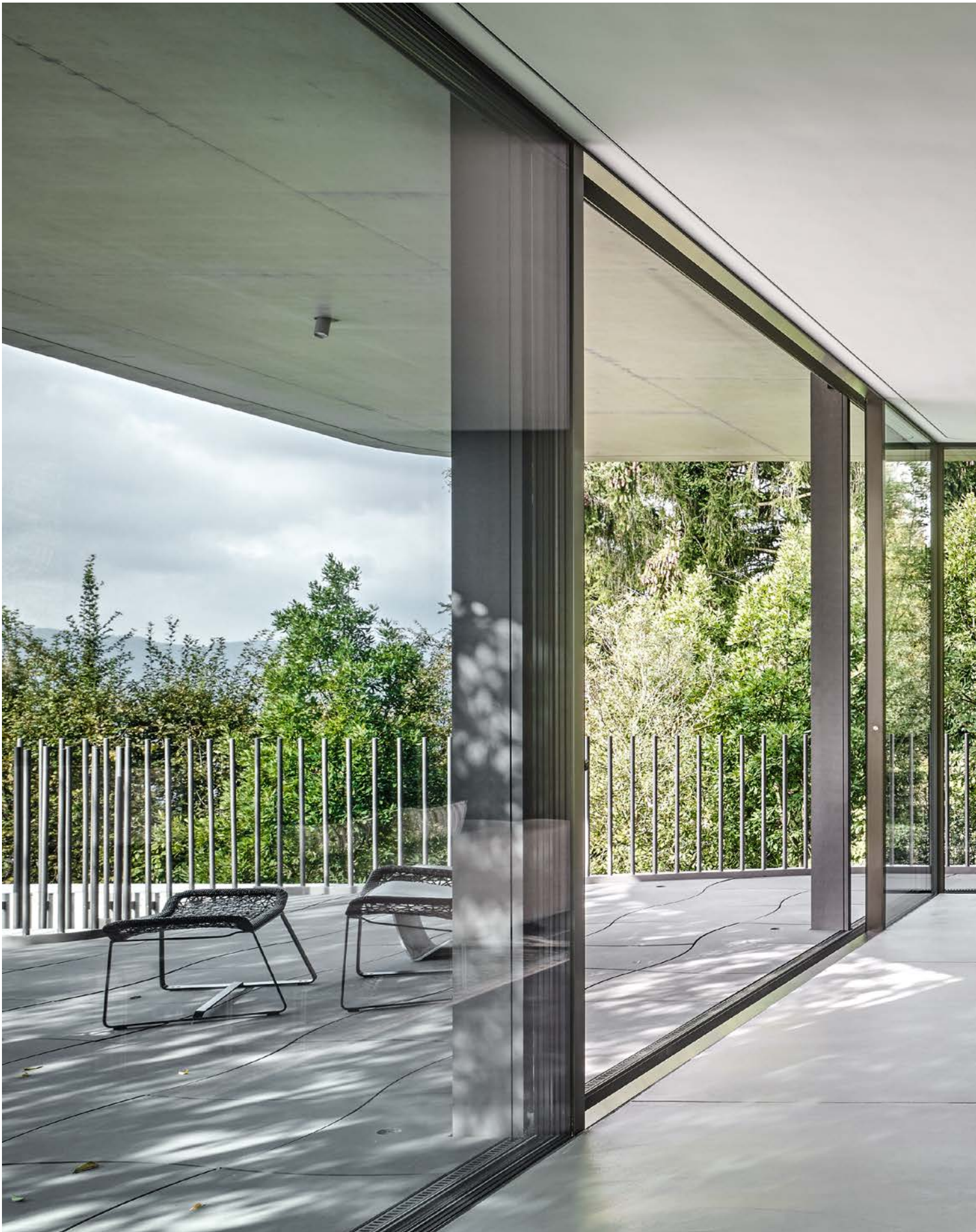
Schiebefenster im geöffneten Zustand
