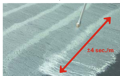
Die Sprühgeschwindigkeit beträgt 4 Sekunden pro Meter.
