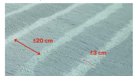
Die optimale Sprühbreite beträgt ±20 cm, mit max. 3 cm Überlappung zwischen den Sprühlinien.
