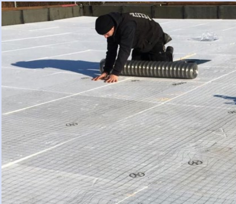
Edelstahlgitter als Kontaktlage zur Verwendung bei SK-Bahnen
