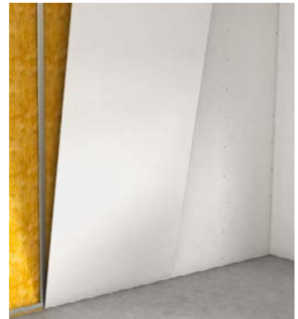
Bekleidung der Metallunterkonstruktion
