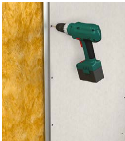
Befestigung mit Schrauben
