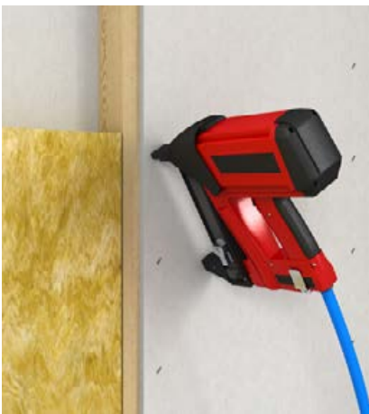
Bekleidung der Holzunterkonstruktion mit Klammern
