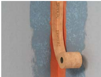
Abb. 2+3: fermacell™ Dichtband in die zuvor aufgetragene, noch feuchte fermacell™ Flüssigfolie drücken und direkt mit Flüssigfolie überstreichen – Trocknungszeit mind. 1 Stunde
