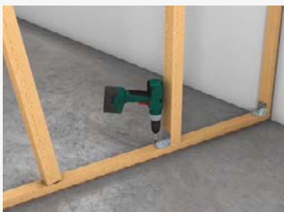
Montage der Holzständer mit Stiftnagel oder Stahlwinkel
