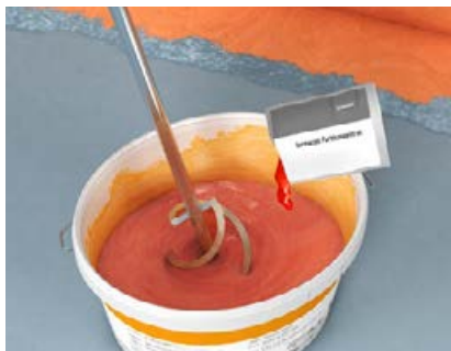
Abb. 8: 2. Auftrag: Farbkonzentrat zur Restmenge der Flüssigfolie geben und homogen einrühren. Eingefärbte Flüssigfolie satt auftragen. Weitere Informationen sind im Produktdatenblatt zu finden. Es ist empfehlenswert, den zweiten Anstrich quer zum Ersten aufzutragen, um evtl. Fehlstellen in der Abdichtungsschicht zu vermeiden.
