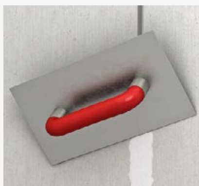
Fugen und Befestigungsmittel verspachteln
