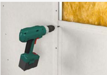
Schrauben auf Stahlunterkonstruktion
