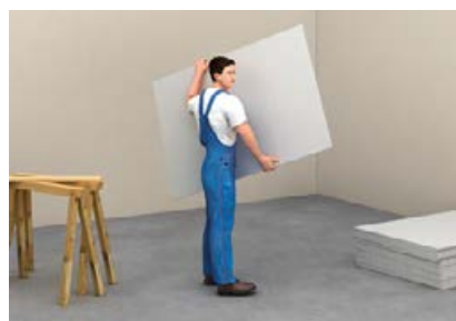
Einzelne fermacell® Gipsfaserplatten hochkant tragen
