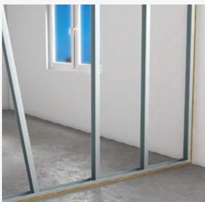
Montage der CW-Ständerprofile
