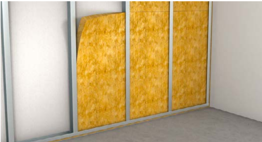
Einbringen der Dämmstoff-Platten
