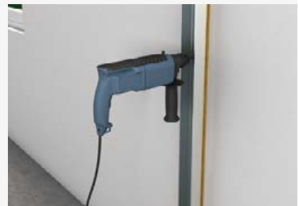
Befestigung der CW-Profile an Massiwand auf Dämmstreifen
