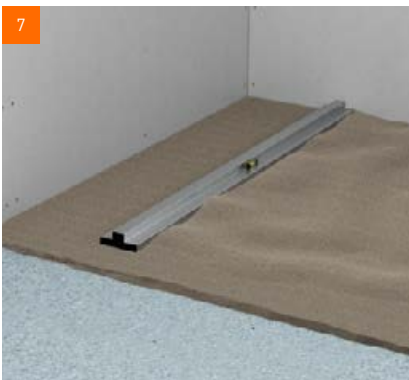
7 ... und auf den leicht verdichteten Dämmen abgezogen
