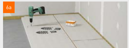
3 Verlegen der fermacell® Estrichelemente
