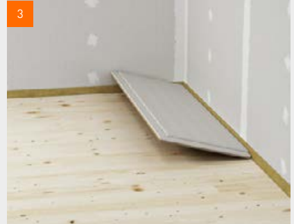
3 Verlegen der fermacell® Estrichelemente
