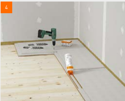
4 Auftragen des fermacell™ Estrichklebers im Falzbereich
