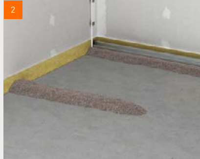
Damm aus fermacell™ gebundene Splittschüttung anlegen
