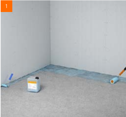
1 Grundierung des Untergrundes mit fermacell™ Tiefengrund
