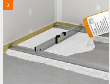
fermacell™ Ausgleichsschüttung einbringen
