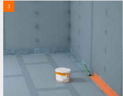
3 fermacell™ Flüssigfolie in der Ecke auftragen
