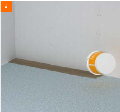
4 Anschließend hat die Gebundene Schüttung T eine erdfeuchte Konsistenz. Der erste Damm wird angelegt
