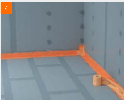
4 In die feuchte Flüssigfolie das fermacell™ Dichtband eindrücken
