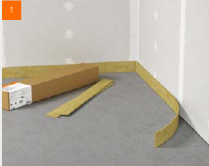
Anbringen der Randdämmstreifen
