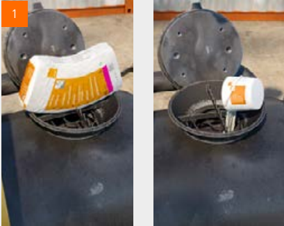
Mischungsverhältnis: 8 Säcke fermacell™ Wabenschüttung + 1 Gebinde fermacell™ Schüttungsbinder
