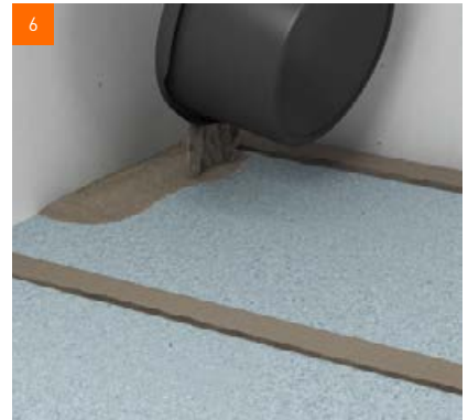
6 Anschließend wird die Gebundene Schüttung T zwischen den Dämmen ausgebracht ...
