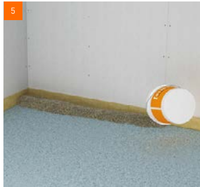
5 Anschließend hat die gebundene Schüttung eine erdfeuchte Konsistenz. Der erste Damm wird angelegt
