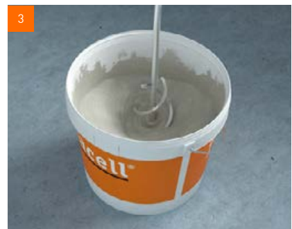
Mit geeignetem Rührgerät bei langsamer Drehzahl anmischen, bis eine homogene, klumpenfreie Nivelliermasse entsteht
