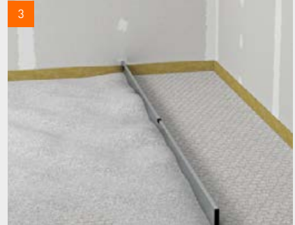
fermacell™ Wabenschüttung abziehen
