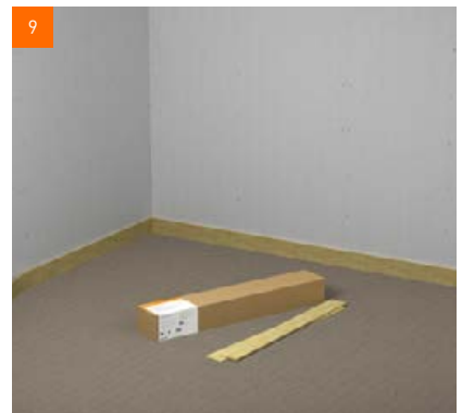
9 Bei Bedarf erfolgt das Anbringen eines Randdämmstreifens
