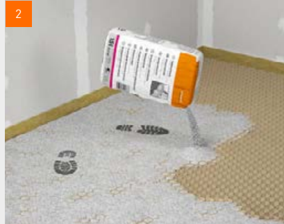
fermacell™ Wabenschüttung einbringen
