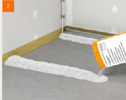
Anlegen der Dämme
