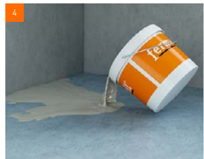
Boden-Nivelliermasse ausbringen und planeben nivellieren
