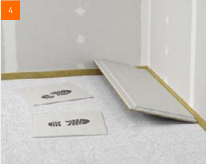
Verlegen der fermacell® Estrichelemente auf fermacell™ Ausgleichsschüttung
