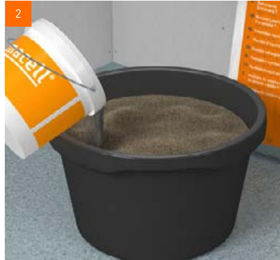
2 Der gesamte Sackinhalt ist in einem geeigneten Mischbehälter mit ca. 7-7,5 Liter Wasser ...
