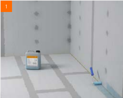
1 fermacell™ Tiefengrund im angrenzenden Wandbereich ...
