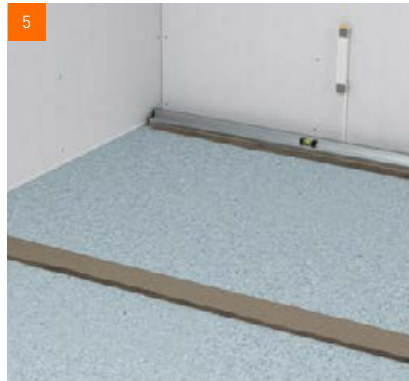
5 Ausrichten der Dämme und diese mit leichtem Druck verdichten
