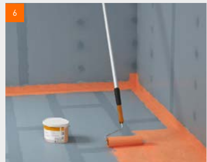
6 Dichtband direkt nach dem Eindrücken mit fermacell™ Flüssigfolie überstreichen - Trocknungszeit mindestens 1 Stunde
