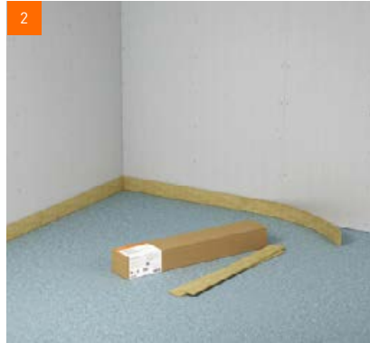
2 Anschließend erfolgt bei Bedarf das Anbringen des Randdämmstreifens
