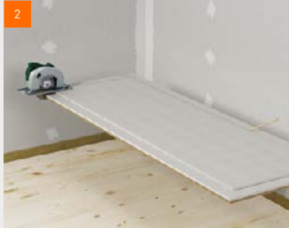
2 Absägen des überstehenden Falzes für die erste Verlegereihe
