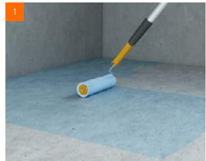
Vorbereitung: Boden grundieren
