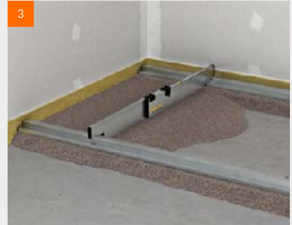
fermacell™ gebundene Splittschüttung abziehen
