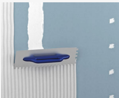
Aufbringen des fermacell™ Leichtmörtels HD mit 5–6 mm Schichtdicke für den Grundputz
