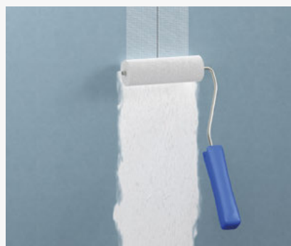
Überstreichen des Armierungsbandes mit fermacell™ Armierungskleber HD
