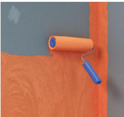
Abb. 7: fermacell™ Flüssigfolie mit der Rolle mind. 2× vollflächig auftragen (Trockenschichtdicke mindestens 0,5 mm). Gemäß DIN 18534-3 wird für den 2. Auftrag ein Farbunterschied zur besseren Nachvollziehbarkeit gefordert.
