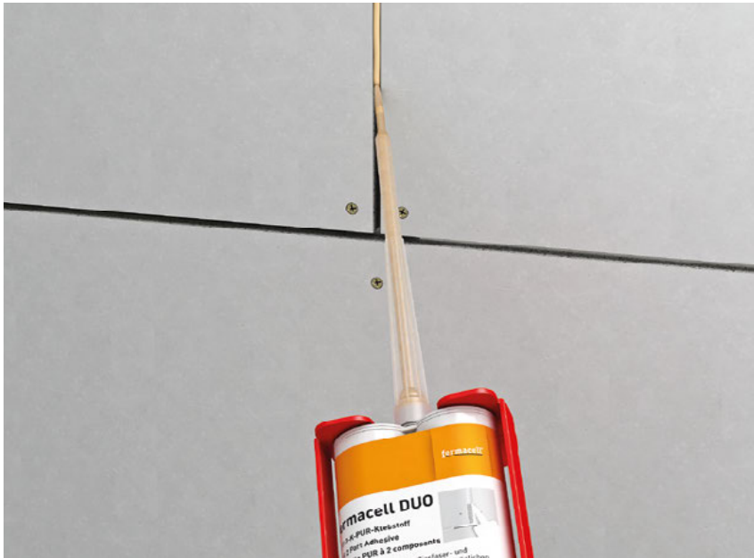
Nachträgliches Verkleben mit fermacell™ DUO Kleber
